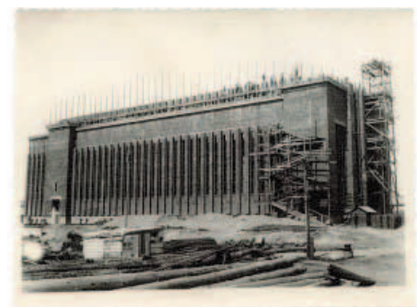
Bažnyčios statybos darbai
